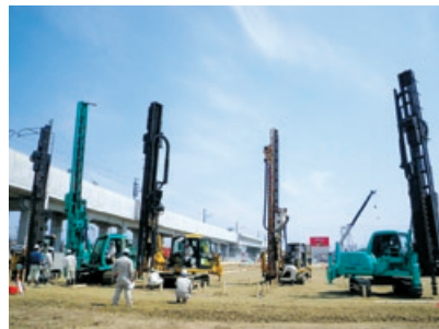
仮設住宅の基礎施工状況
