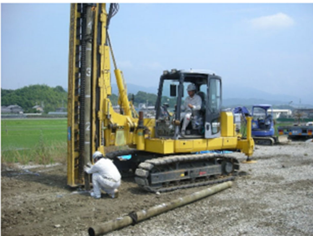
「SH-KPパイル工法」の施工状況
