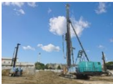
三点式重機と狭小箇所における小型重機による施工状況
