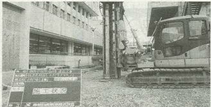
同社施工の公共物件、相馬市役所南庁舎の建設工事に木杭の環境パイルが採用
