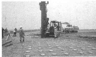
宮崎市佐土原で実施された宮崎県産杉丸太の打設実験
