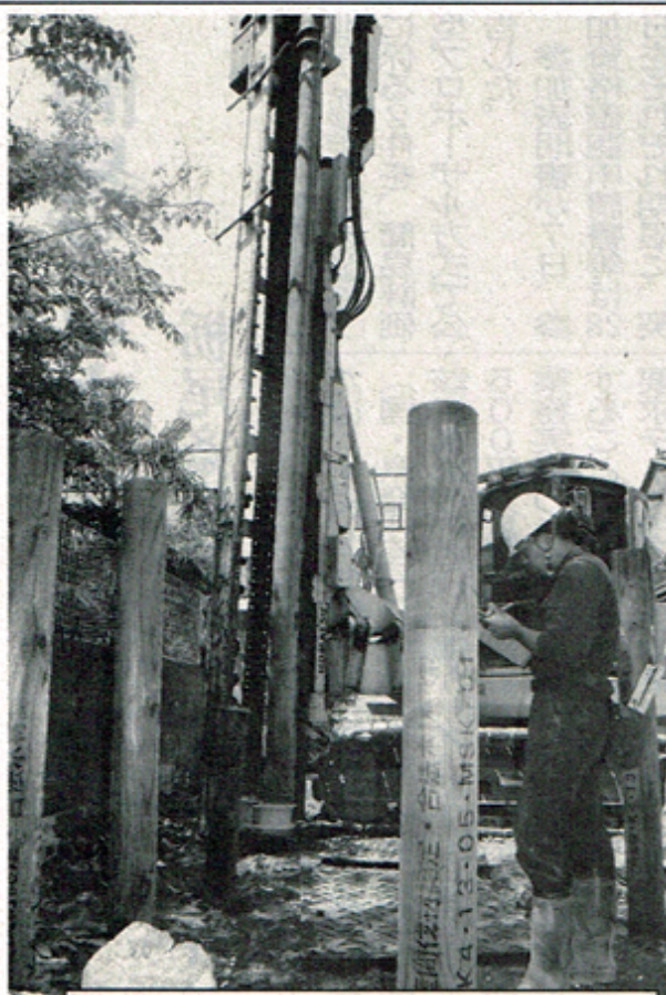
環境パイル工法を採用した福井市左内町の建設現場
