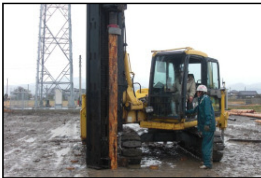
小型施工機械による丸太の打設状況
