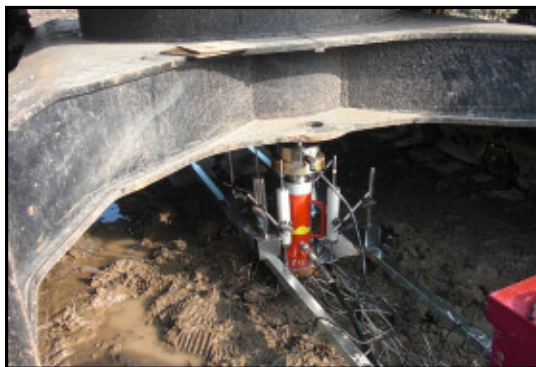
載荷試験状況
