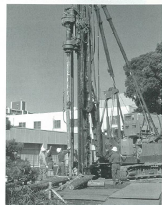
③今回適用された工事での丸太打設状況
