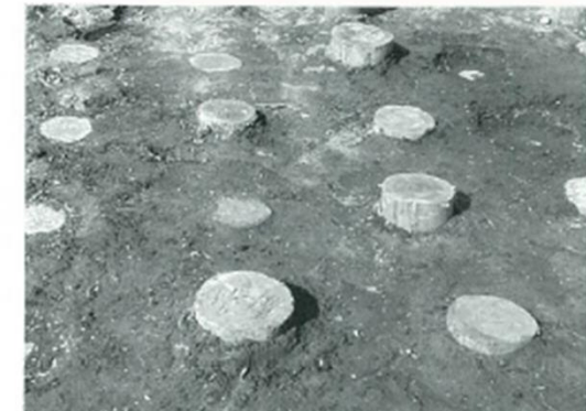
②2012年度の実証実験：打設された丸太の状況
