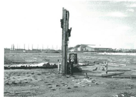
①2012年度の実証実験：小型施工機械による丸太の打設状況
