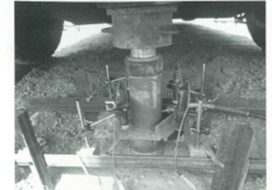
◎載荷試験状況
