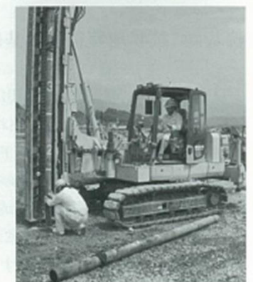
◎木杭打設状況
