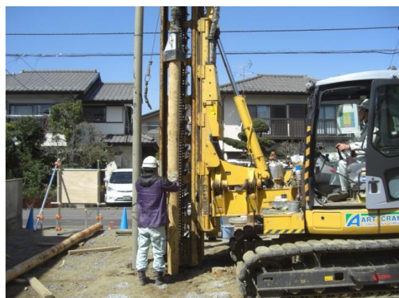
写真-2 丸太の打設状況
