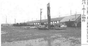
環境パイル工法を採用した地盤補強工事。木村利用ポイントが活用されている。
