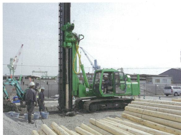
写真1 丸太打設液状化対策工法の実証実験（高知市仁井田地区）
