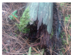
未処理杭 (2014年1月)
