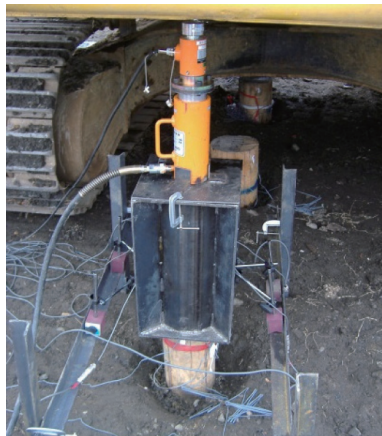
写真-3 載荷試験実施状況
