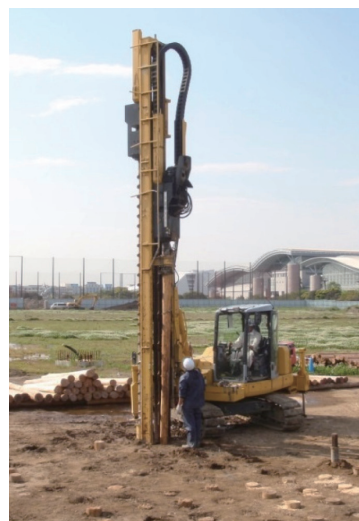
写真-8 施工状況
