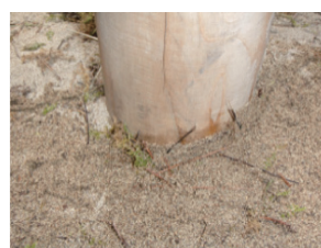
未処理杭 (2008年9月)
