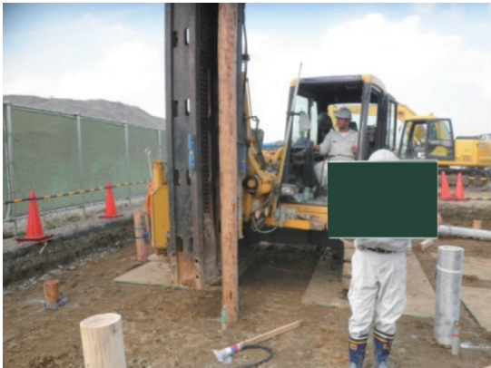
写真-6 Wbtp施工状況
