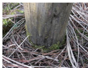
未処理杭 (2013年2月)
