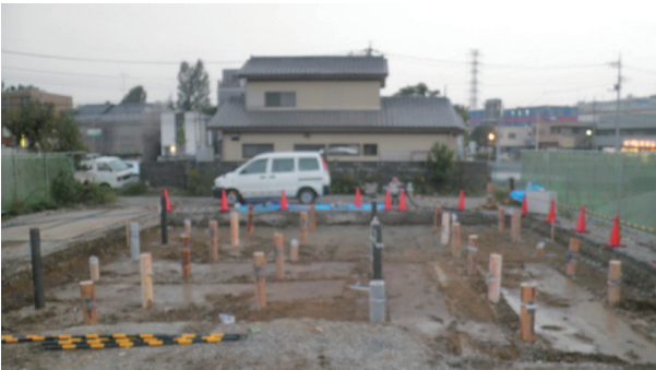
写真-5 試験ヤード全景
