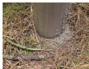
未処理杭 (2011年6月)
