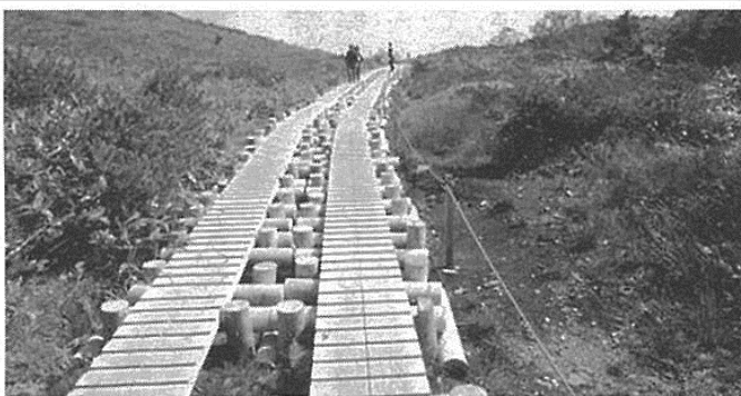
中部山岳国立公園内に施工された県産材の木道
