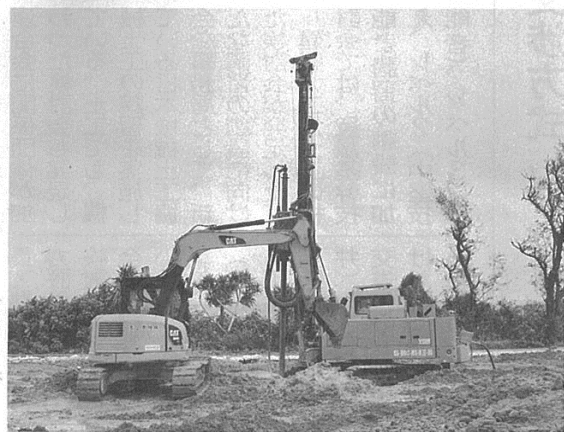
施工中の様子
