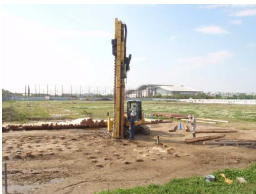
小型施工機械による丸太の打設状況
