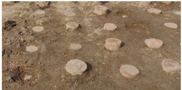
実証実験現場に打設された丸太の状況
