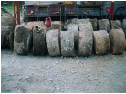
写真-6 パイル切断状況
