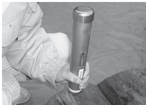
図6 ピロディン試験実施状況 Fig. 6 Pilodyn test implementation status
