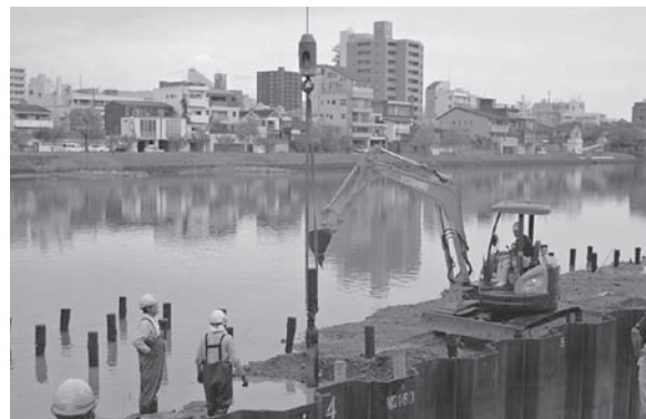
図5 杭出し水制工の引抜き状況 Fig. 5 The actual situation of pulling out the tree groyne
