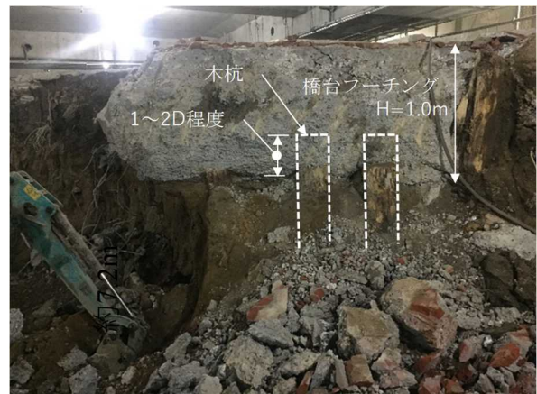
図-5 橋台と杭頭部の接続状況
