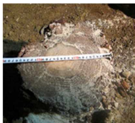
図-31 木杭載荷面の状態
