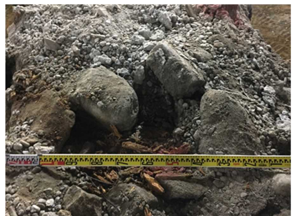
図-6 橋台フーチングの基礎砕石
