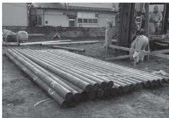
写真7 環境パイル工法で使用する木材
