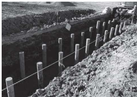
写真9 擁壁下の環境パイル工法
