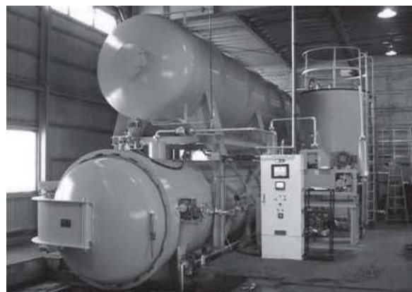
写真1 加圧注入処理装置
